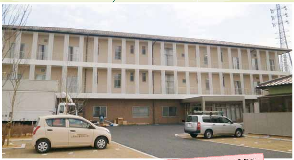
新しく開設した「優・悠・邑 和合」の外観です。
